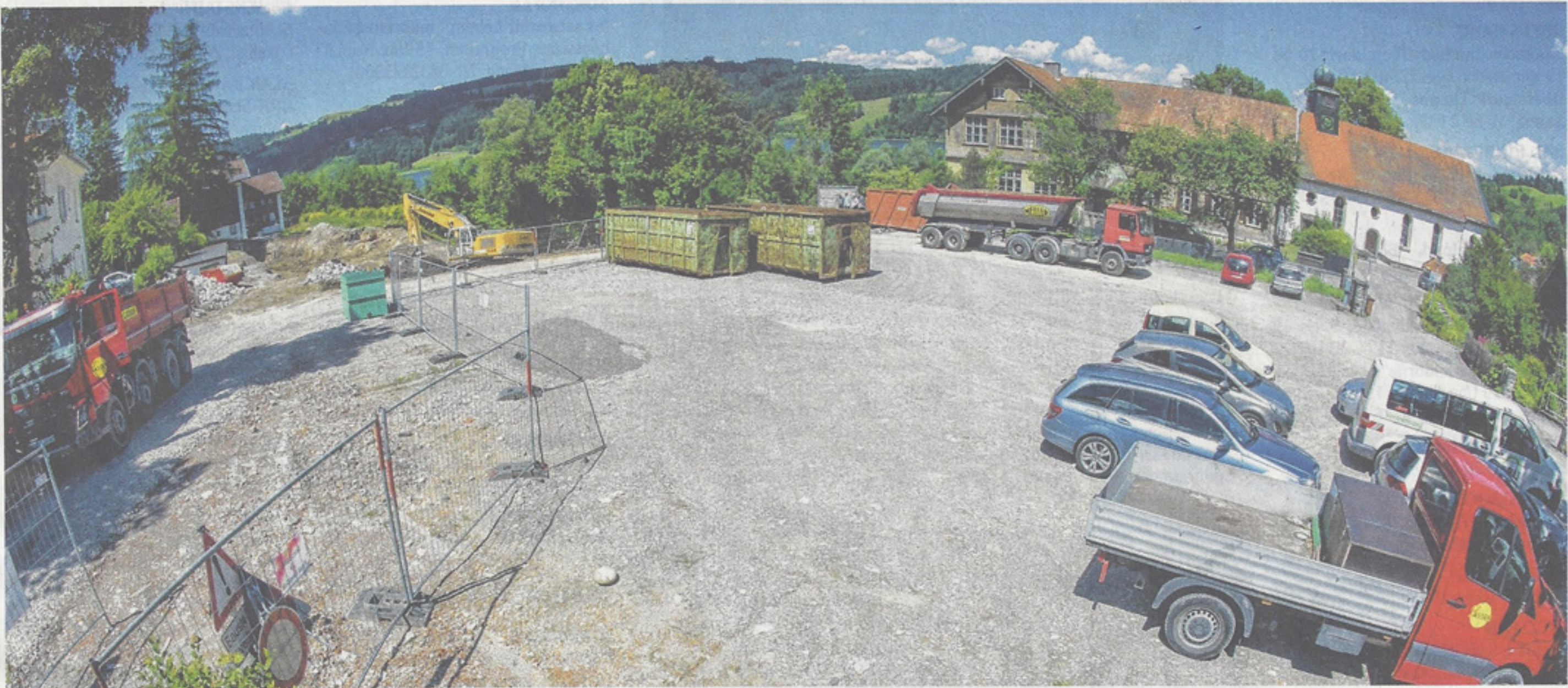
An dieser Stelle stand einmal die ehemalige Alpsee-Klinik für Kinder und Jugendliche St. Michael. Jetzt ist das Gebäude verschwunden, die Bagger graben noch die letzten Fundamente (links im Bild) aus. Danach soll an der Stelle ein großer Parkplatz mit 104 Stellflächen entstehen (siehe Grafik). Rechts im Hintergrund sind die Alte Schule und die Kirche St. Stephan zu sehen. Foto: Dominik Berchtold
